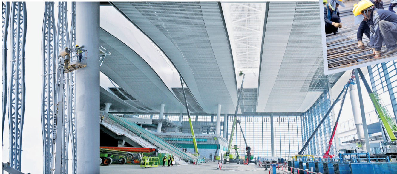
工人正在对立柱进行安装作业。
