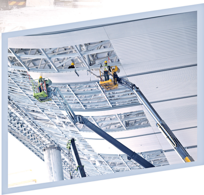
工人正在升降机上安装吊顶铝板
