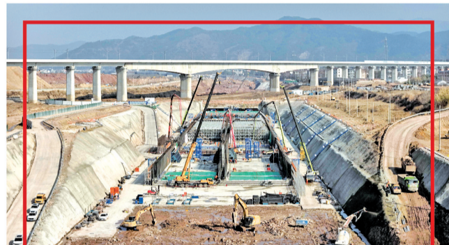
甬金高速公路改扩建工程涉双江湖路段土建工程,隧道区域建设现场。
