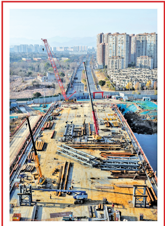
富港大桥工程建设现场,桥面钢梁正在施工中。
