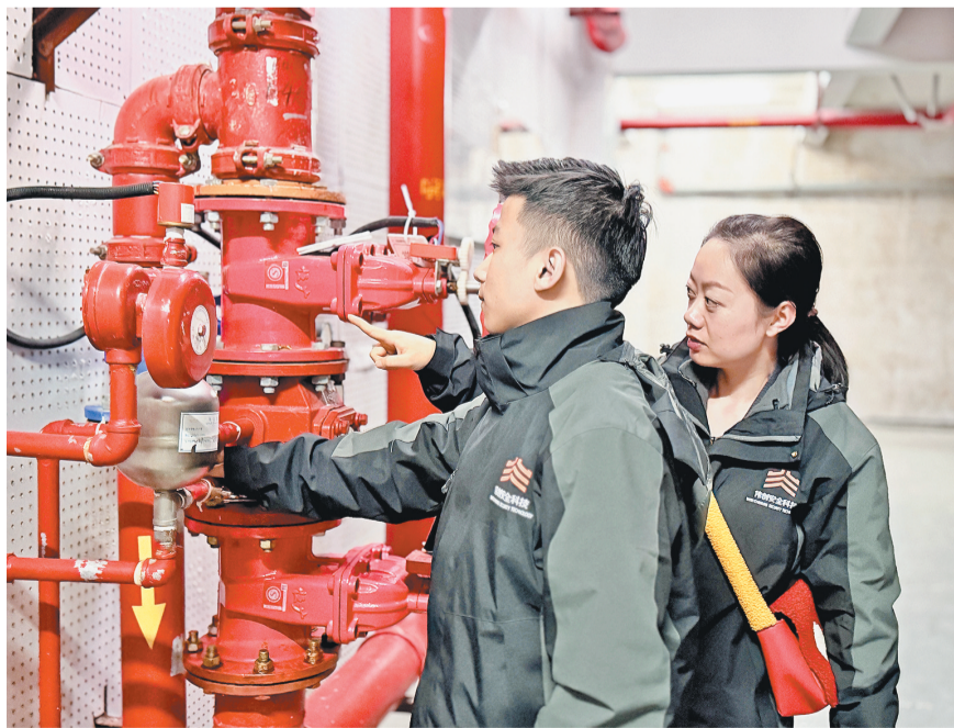
专业消防检测人员为高楼“体检”。
