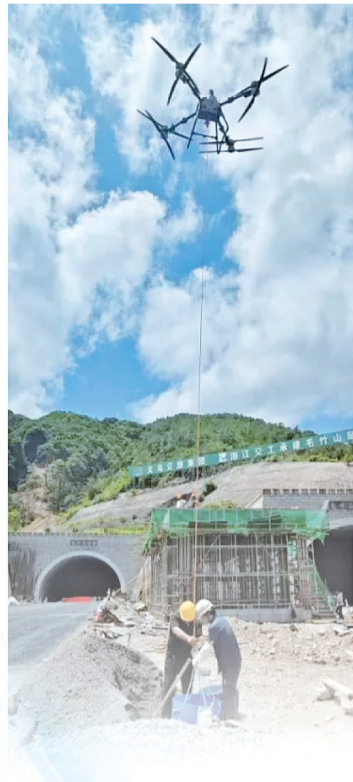
无人机在江赤公路项目现场吊运建材。
