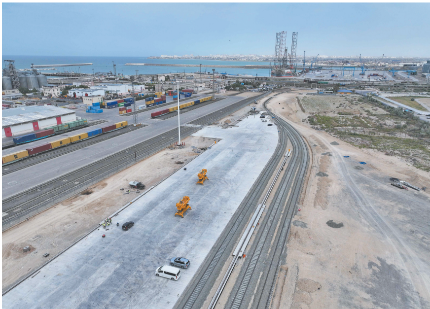
这是8月5日在哈萨克斯坦阿克套港拍摄的阿克套港集装箱枢纽一期工程建设场景(无人机照片)。 新华社记者 李任滋 摄
