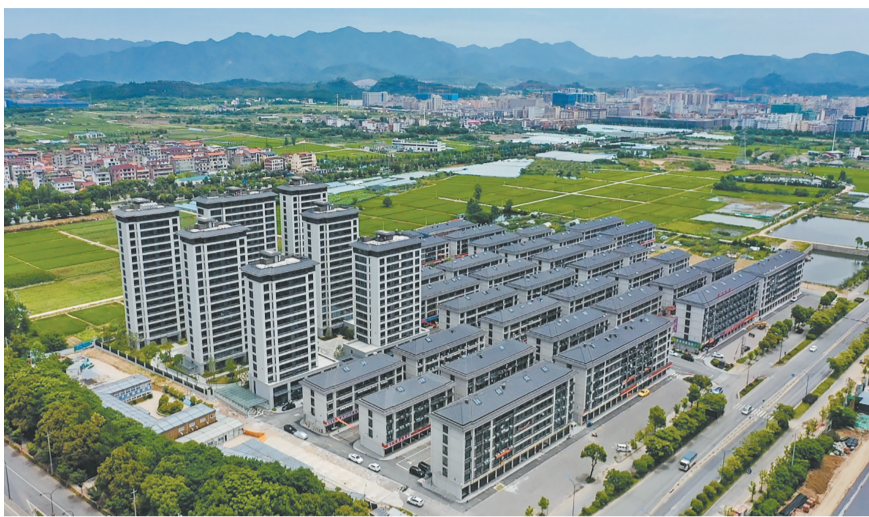
航拍下华店村新建的库存专业街。
