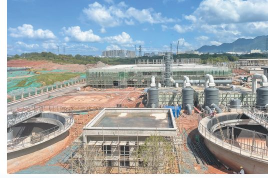
武德净水厂二期。
