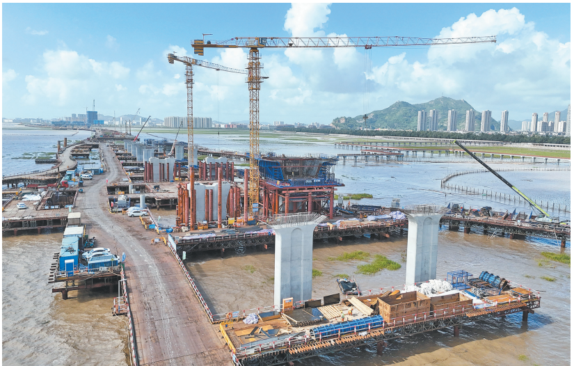
9月17日,在浙江省温州市乐清湾滨海大道桥梁建设现场,工人在项目工地施工(无人机照片)。
