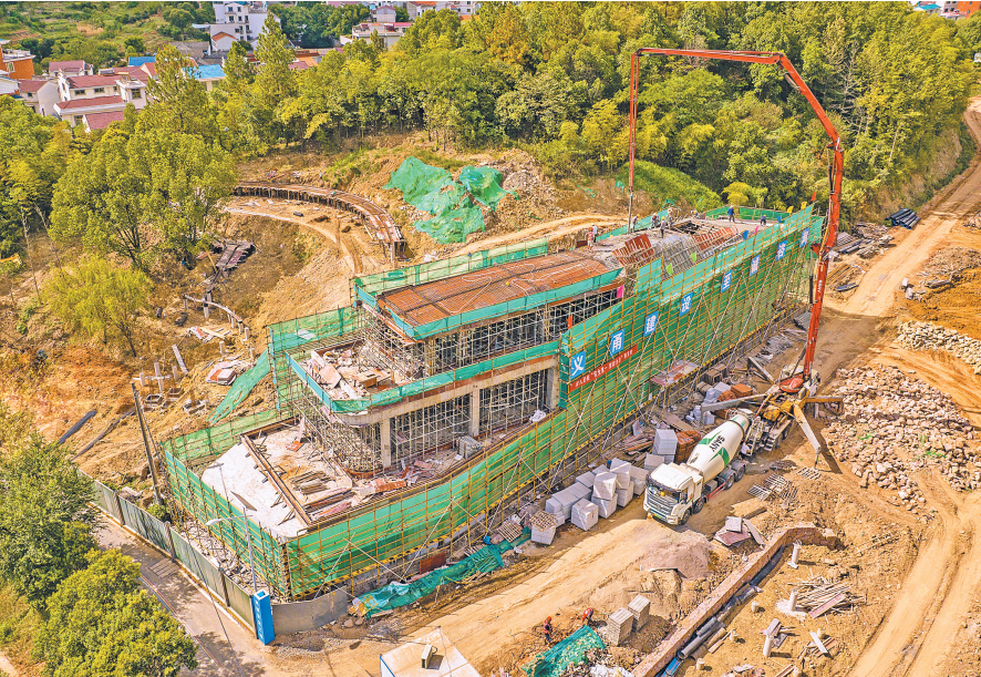
7月30日,“大李祖”第一个共富项目——李祖梨文化创意中心主体建筑顺利结顶。
