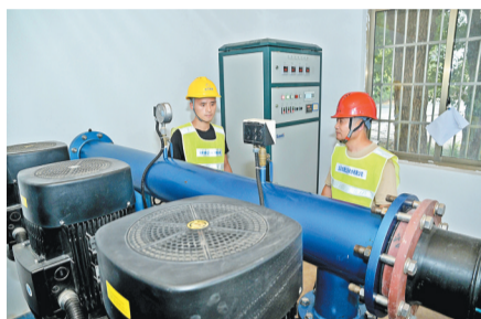
巡查供水设备。
