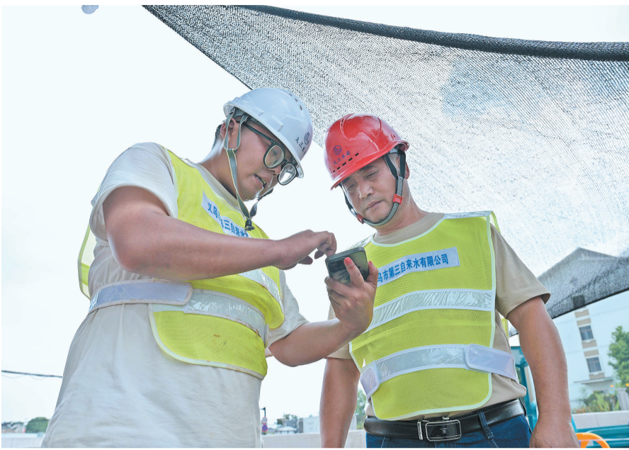
现场核对施工电子图。
