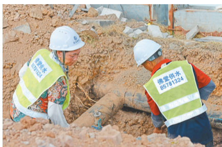
供水管道改造。
