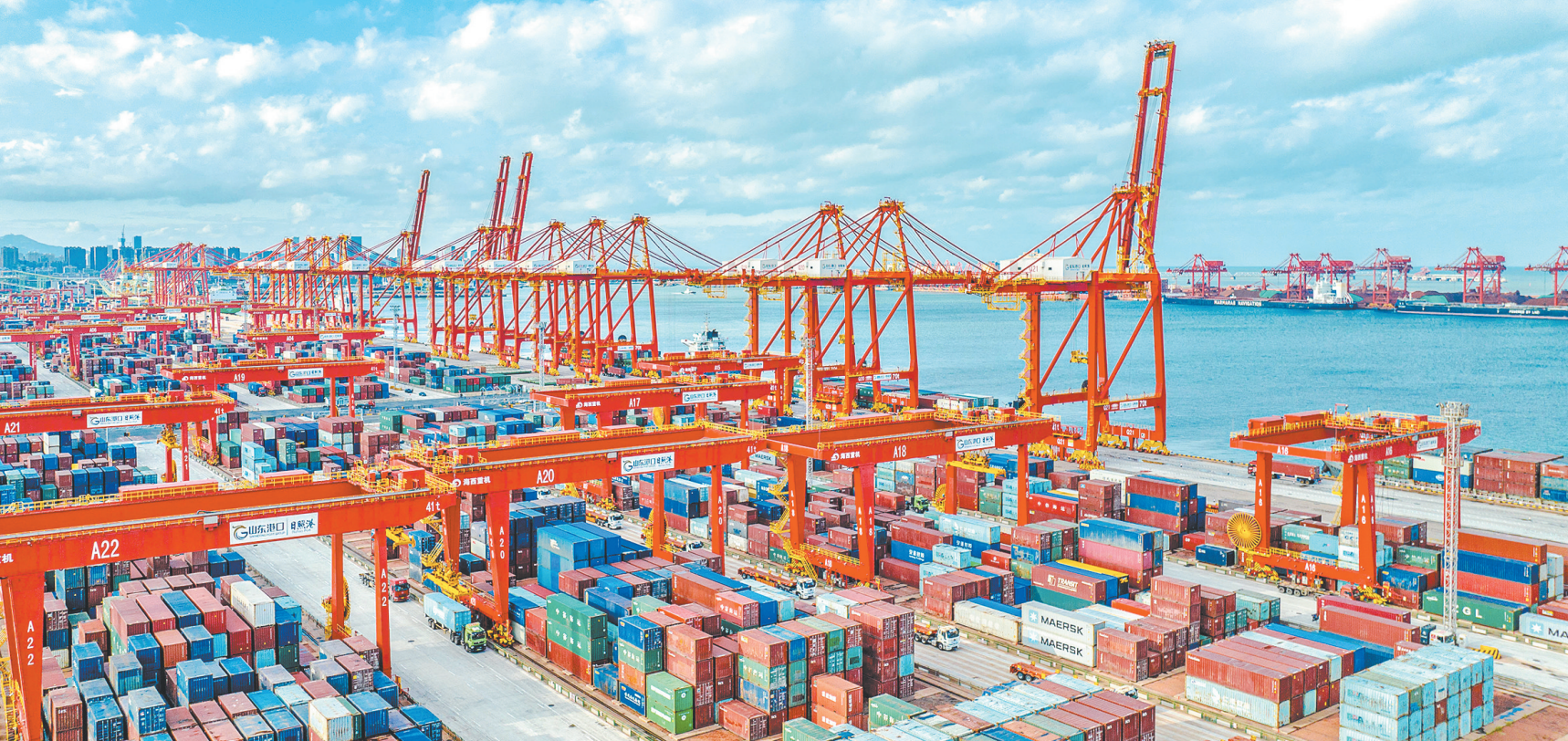
2024年7月2日拍摄的山东港口日照港集装箱码头(无人机照片)。 新华社记者 郭绪雷 摄
