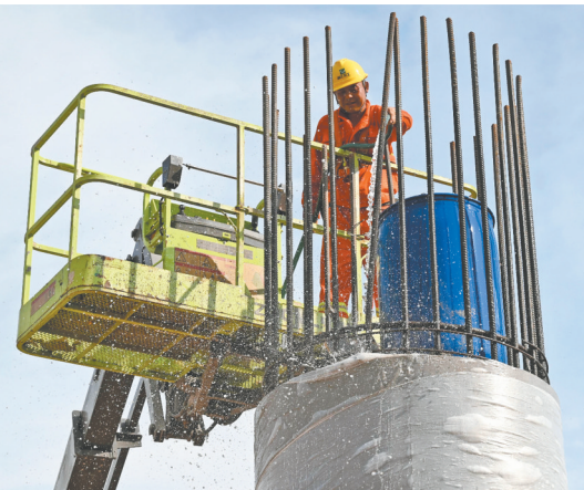
桥墩“越长越高”,建筑工人站上登高车为新浇筑的混凝土洒水养护。
