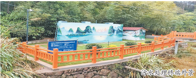
污水处理终端外景
