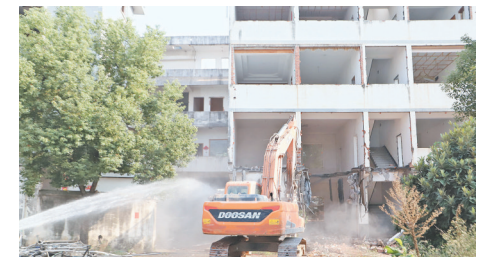
旧房拆除现场。
