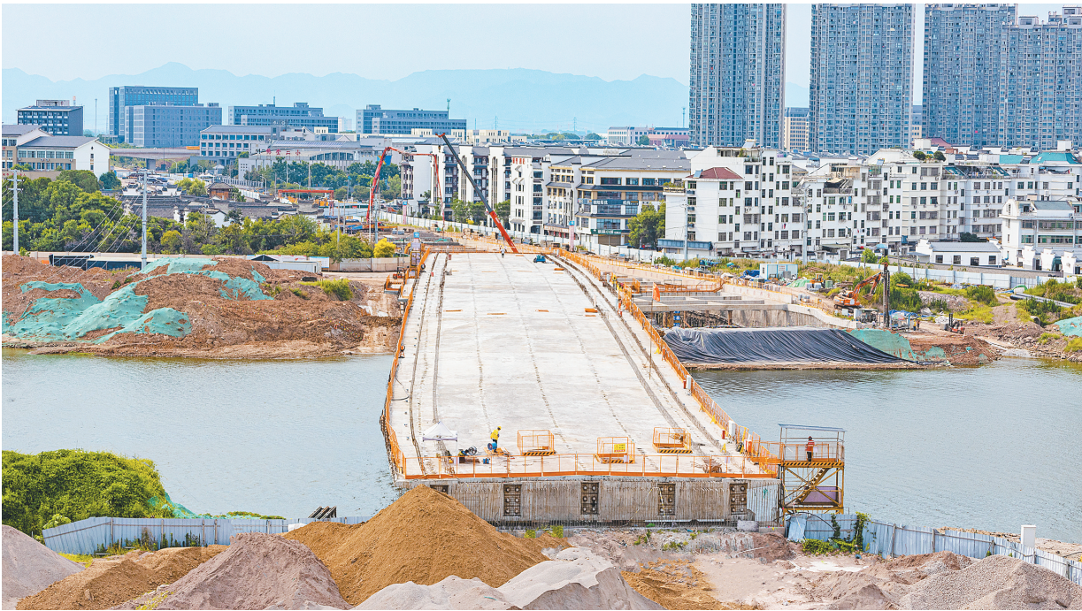
建设中的渡磬桥。
