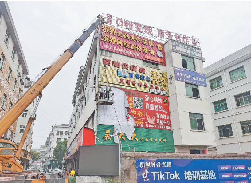
拆除违规设置的户外招牌现场。
