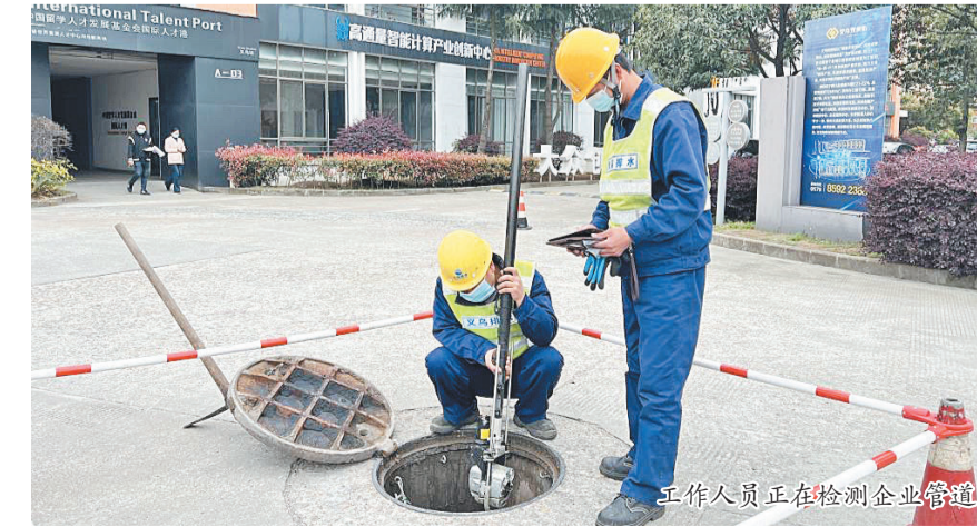
工作人员正在检测企业管道
