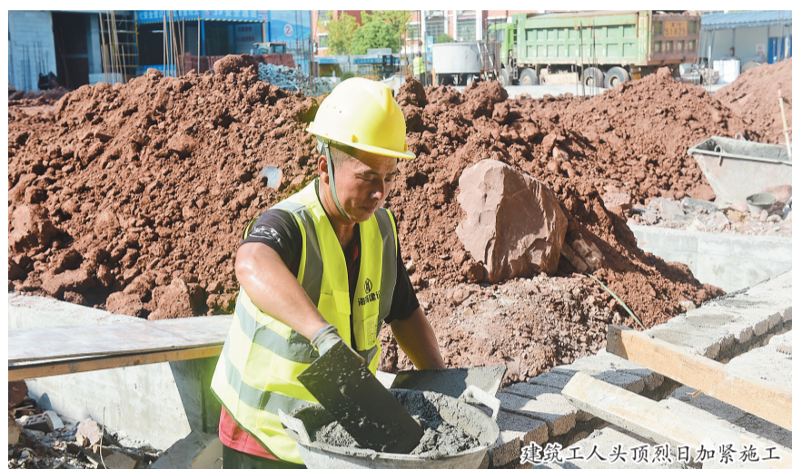
建筑工人头顶烈日加紧施工
