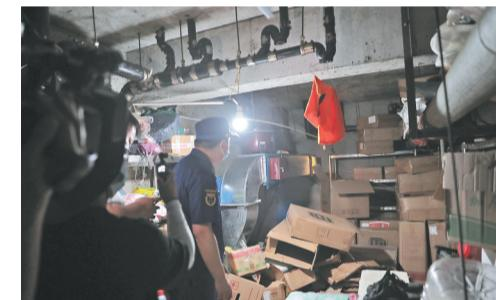
检查发现阁楼电线私拉乱接,电线下堆放可燃物。
