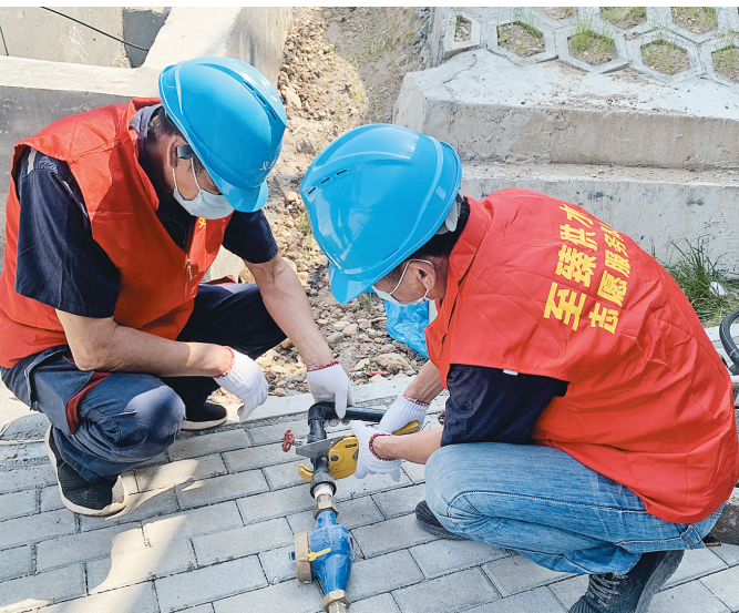
“供水人”正在暖心服务点上安装自来水。
