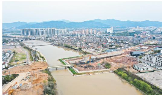
3月20日,备受关注的G527与临苍公路义乌佛堂联络工程朝阳路过江下穿隧道建设现场,一派繁忙景象:隧道围护钻孔桩、抗拔桩、格构柱施工,隧道土方开挖、侧墙建设等同步进行。截至目前,完成总工程量的21%。
