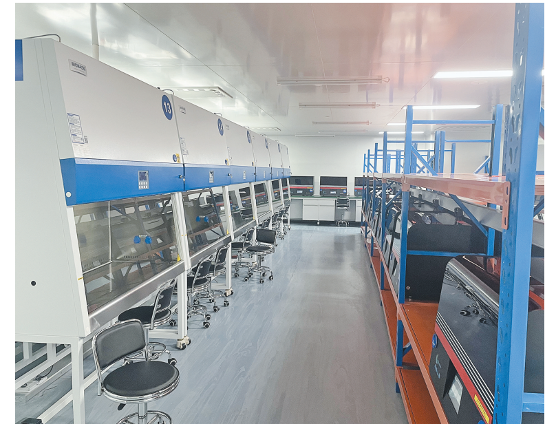
浙大四院负责建设的核酸检测基地。
