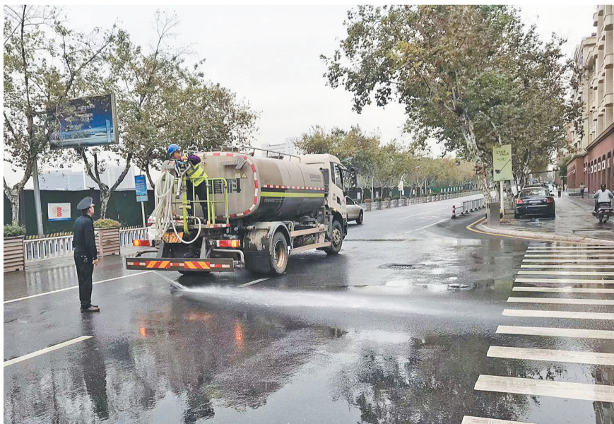
在建工程施工人员冲洗路面,清除清运车辆扬尘。
