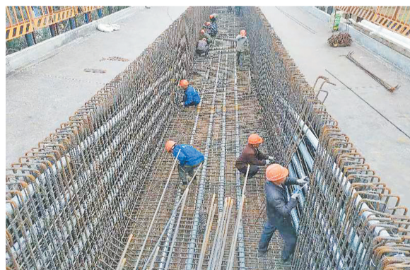
后宅街道吴宅村特大桥现浇梁施工现场。
