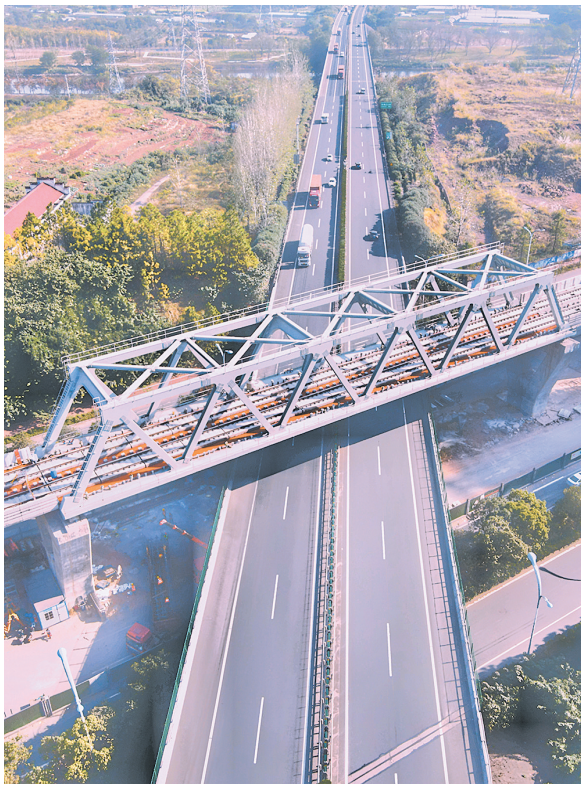
金义东市域轨道交通工程义东线首通段跨甬金高速钢桁梁。
