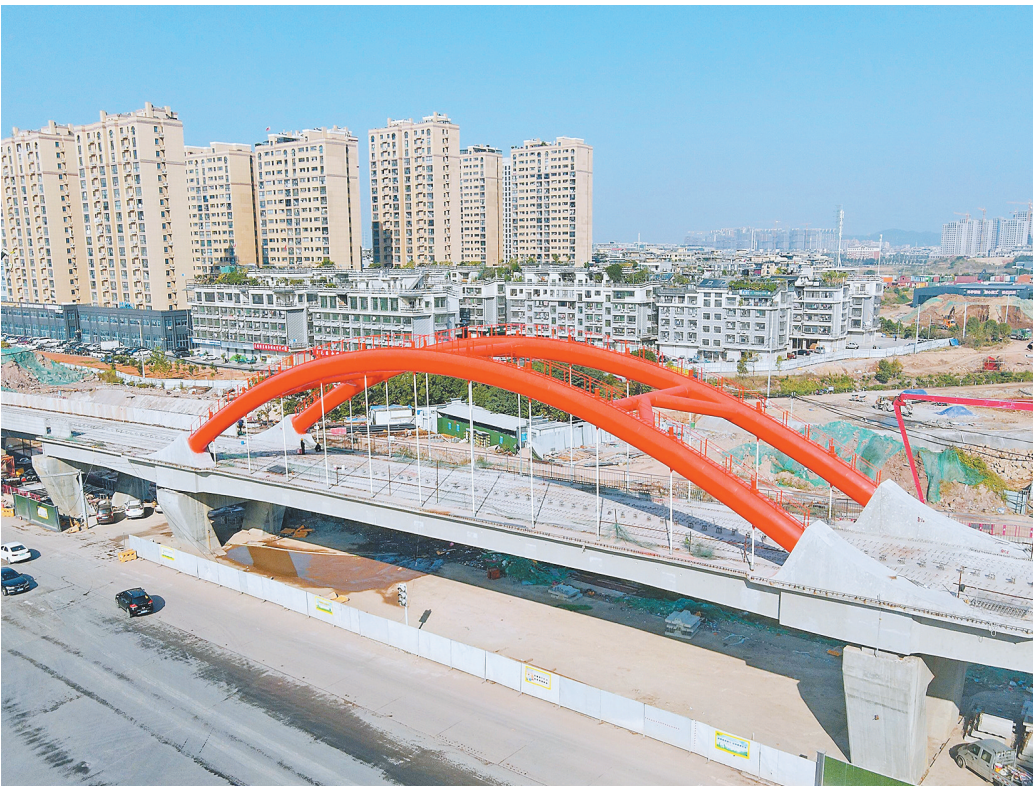
金义东市域轨道交通工程义东线首通段兴隆大街系杆拱桥。
