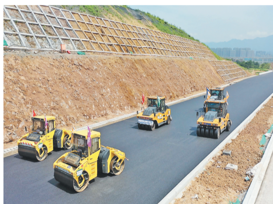
江东连接线施工现场。
