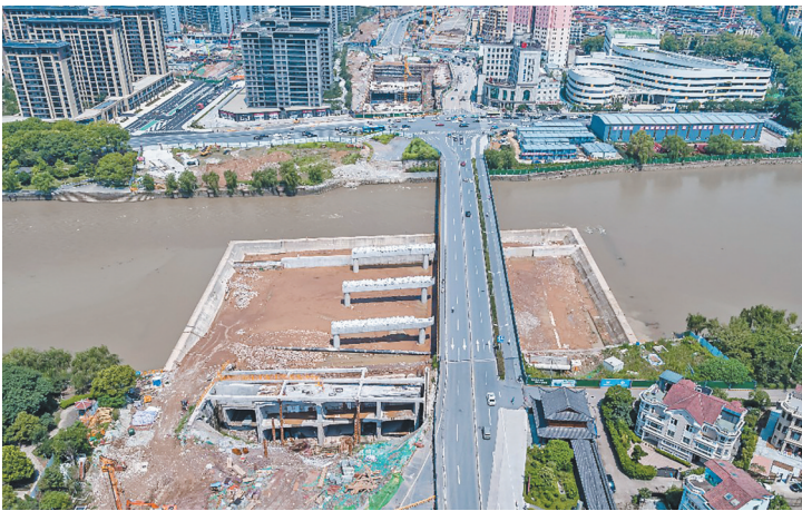
机场路立交化改造工程三阶段。
