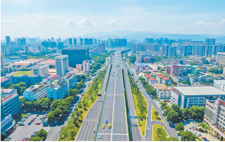
机场路立交化改造工程二阶段。
