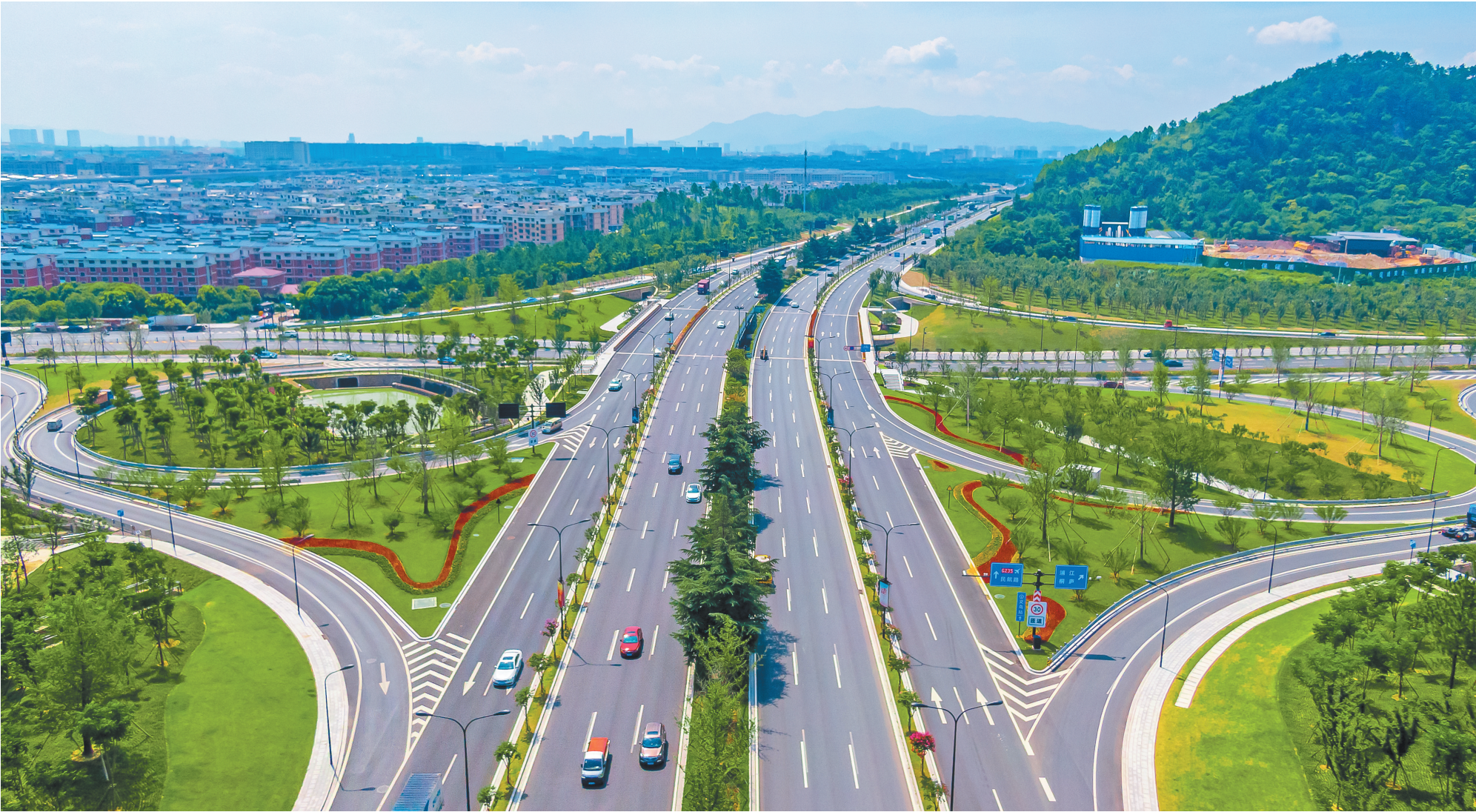
机场路立交化改造工程一阶段。
