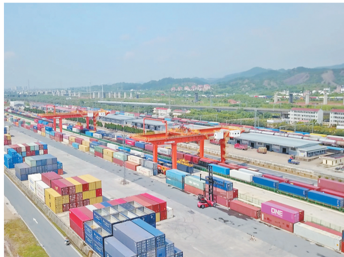
义乌铁路口岸航拍图。
