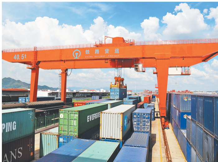
龙门吊正在吊装集装箱。
