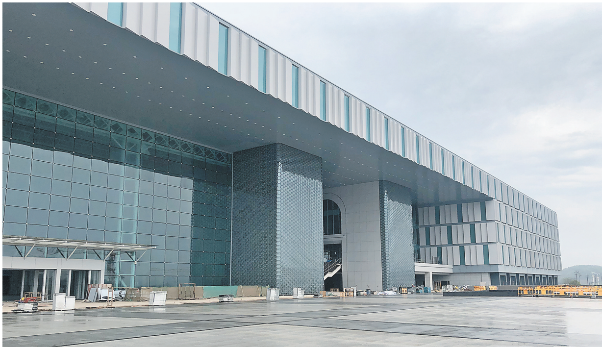
枢纽大楼正在进行内部精装修。
