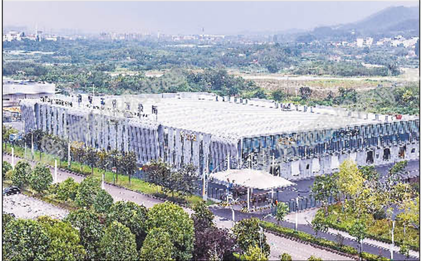
义乌国际邮件互换局,按照海关监管场所建设标准建造,采用围网、卡口等封闭式管理。
