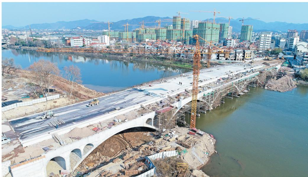
1月19日，佛堂古镇伏虎桥桥面主车道沥青铺设完成。平侧石、桥梁护栏等安装施工也同步进行。经过一年半的紧张施工，伏虎桥改造工程预计春节前主体完工，具备通车条件。
